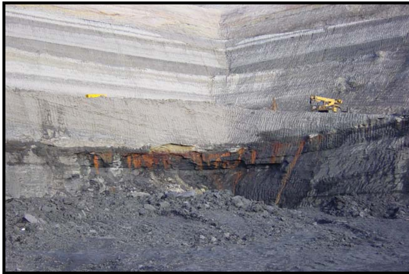
Estudio de estabilidad de taludes en el frente de explotación de la corta Gargallo (Teruel)
