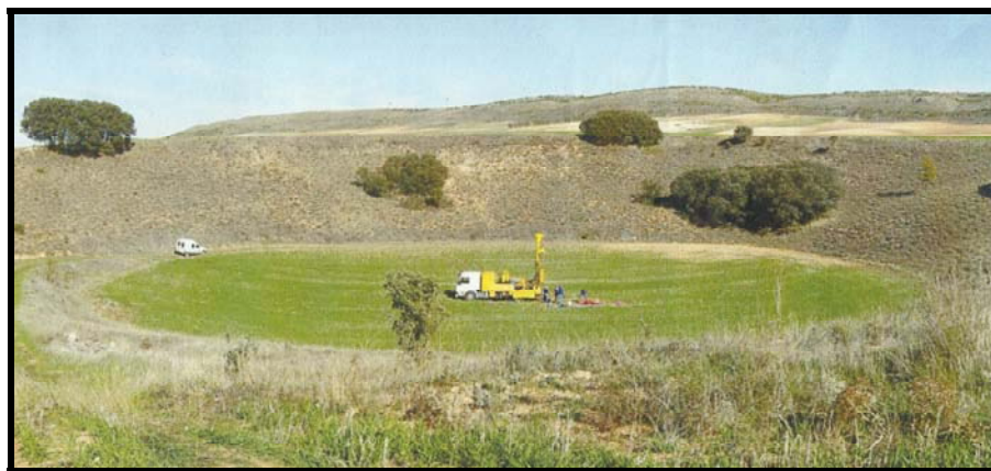
Realización de sondeo en dolina (LAV Madrid – Valencia)
